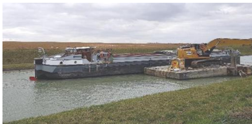
Figure 26 : Illustration d'un dragage mécanique d'une pelle sur ponton (source : VNF)
