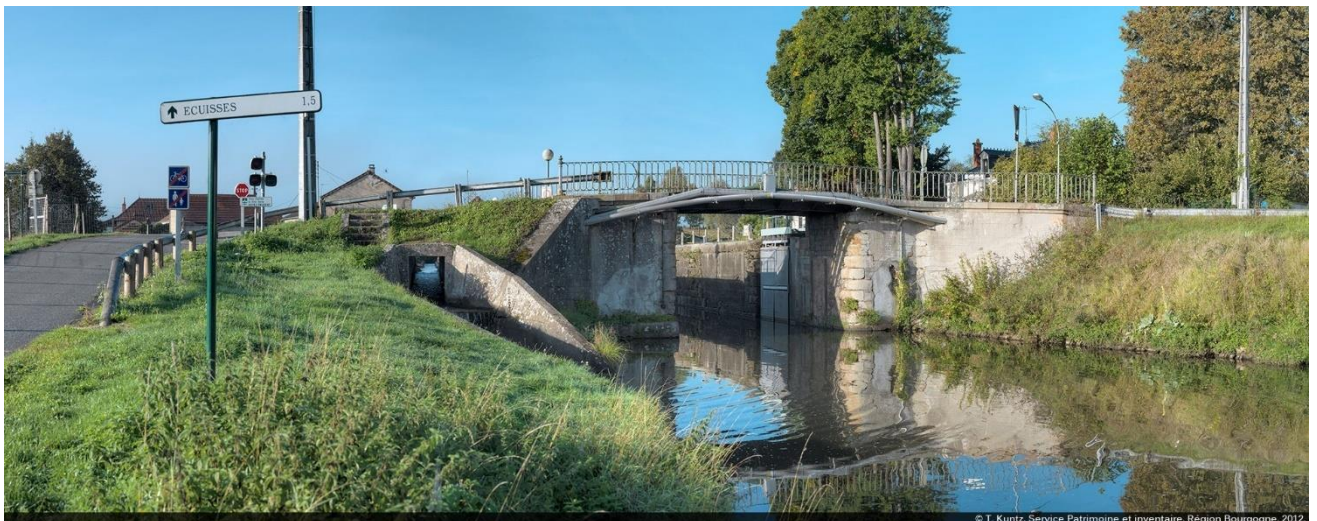
Arrivée de la rigole régulatrice des biefs au bief 5 du versant Méditerranée à Ecuisses
