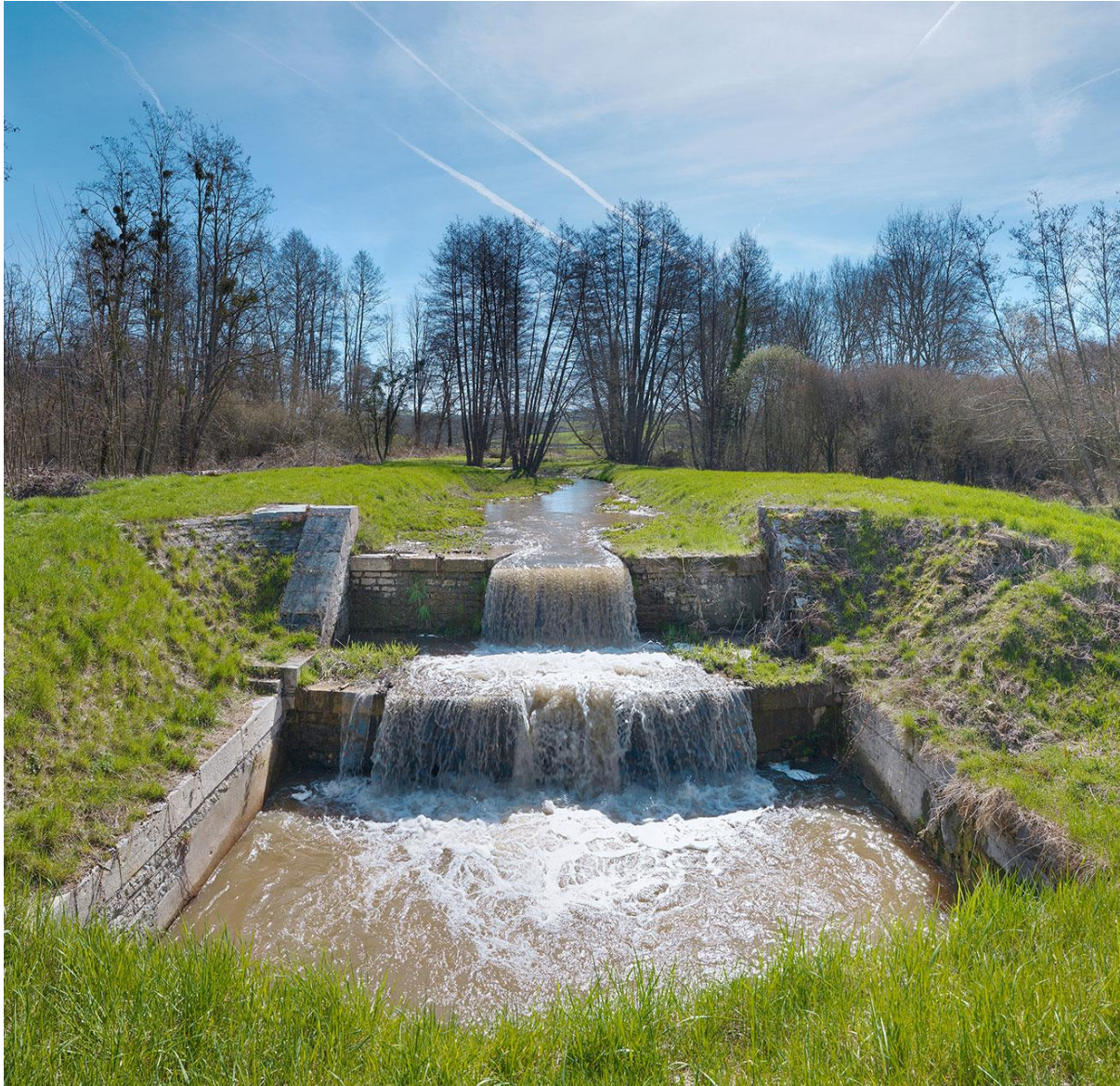
Le palier et le bassin de décantation de l'aqueduc permettant au ruisseau de Verrière de passer sous le canal, en amont du site de l'écluse 11 du versant Méditerranée à Saint-Julien-sur-Dheune
