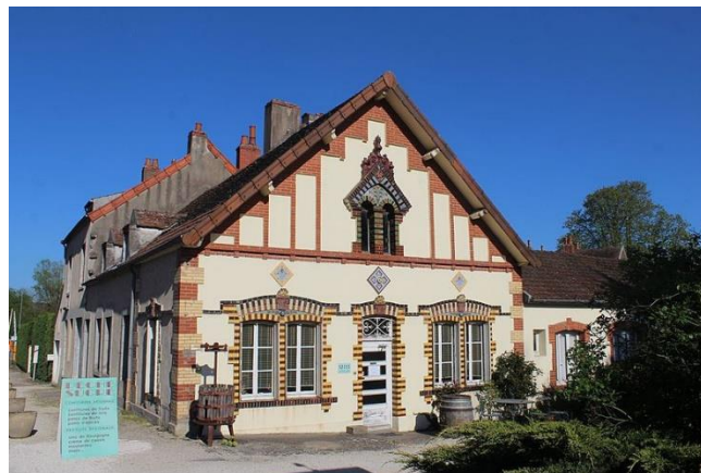
Saint-Léger-sur-Dheune Bureaux Ancienne Tuilerie Perruson-Desfontaines
