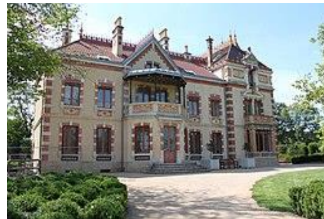
Ecuisses Ancienne tuilerie Perruson
