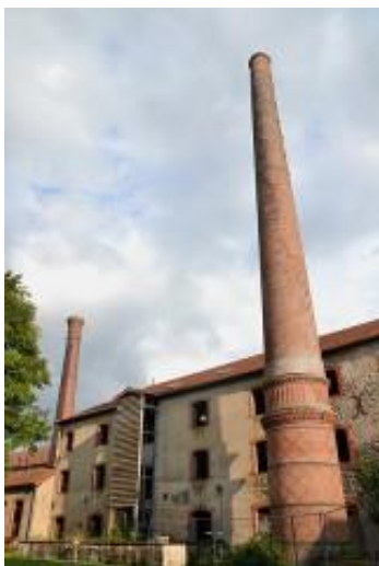
Ciry-le-Noble Briqueterie des Touillards
